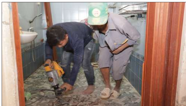
Démontage du carrelage au sol des toilettes
