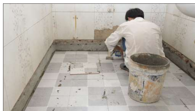
Pose du carrelage des toilettes
