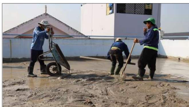
Préparation du sol avant la pose du carrelage
