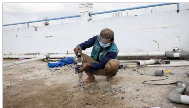
Démontage du carrelage au sol
