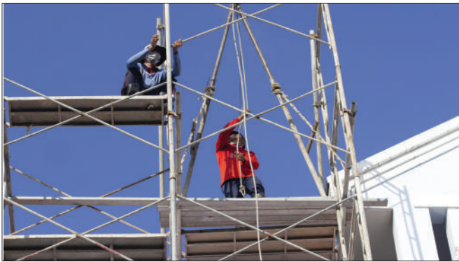
Công nhân đang chuyển vật liệu lên mái nhà.
