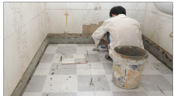
Công nhân tiến hành lát gạch lại nhà vệ sinh.
