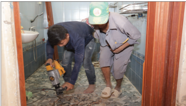
Đục bỏ lớp gạch thấm trong nhà vệ sinh.
