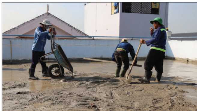
Công nhân đang rải bê tông trên sân thượng.
