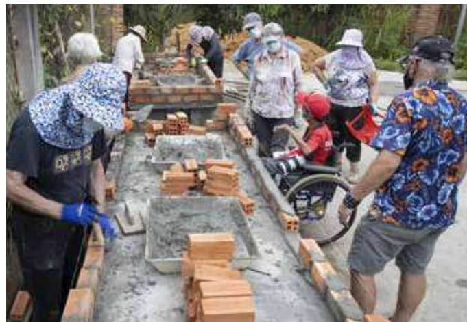
Đoàn Casira đang xây bờ bo để đổ đất vào cho bồn trồng rau trị liệu.
